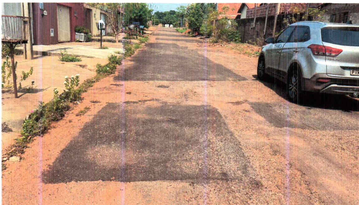
Rua 08, setor Vila Nova.
